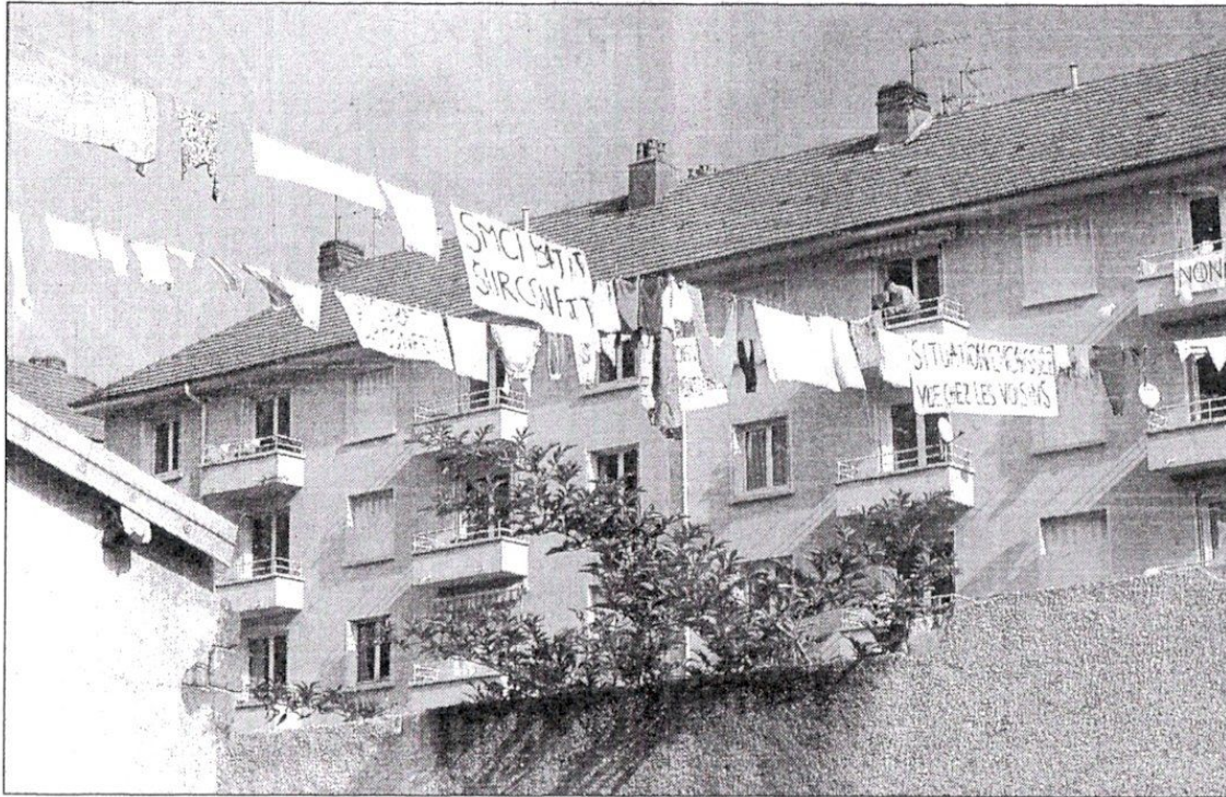
Ambiance napolitaine pour polémique épineuse. C'est la construction du nouvel immeuble baptisé « Via Rotonda », qui attise la colère des riverains du 24, rue de la Rotonde.
